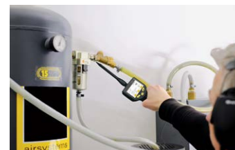
Leckagesuche mit Richtrohr
